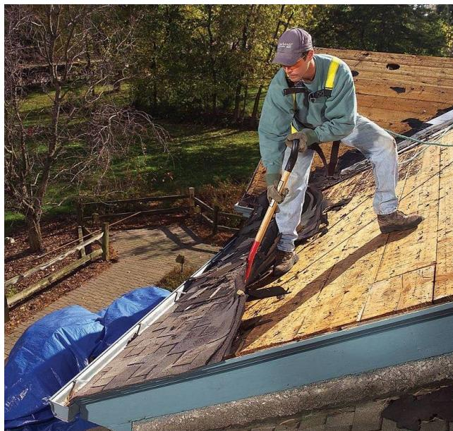
Чтобы не возвращаться к ремонту кровли чаще, чем того требует замена кровельного материала, важно верно применять строительные плёнки и учитывать возможные причины повреждения утеплителя. Так, отсутствие или недостаточная вентиляция подкровельного пространства приводит к тому, что влага не выходит из конструкции и приводит к намоканию утеплителя и древесины, образованию плесени и грибка, деформации элементов из древесины. Пенопласт или пенополистирол повреждают грызуны.
