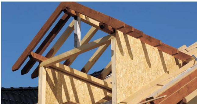
Редкая крыша не имеет слухового окна. Они служат украшением и одновременно выполняют утилитарные функции - освещают и вентилируют чердачные помещения, обеспечивают выход для обслуживания и ремонта кровли. Существует множество различных типов слуховых окон, отличающихся внешним видом и конструкцией, но все они расположены на крыше, а значит уязвимы для протечек.
