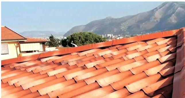
Щипцы, или ветровые планки, устанавливаются на фронтовых свесах крыши и служат для защиты подкровельного пространства от попадания осадков, задувания ветра и проникновения птиц. Кроме того, щипцовые элементы выполняют декоративную функцию и закрывают выступающие конструкции стропильной системы.
