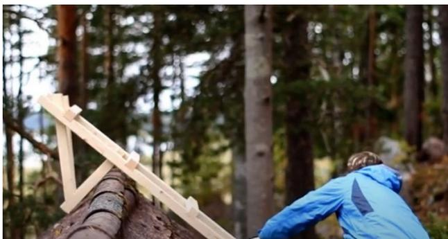
Опора необходима, чтобы «клюв» не повредил кровельные листы на противоположном скате сразу за коньком. Также опора способствует хорошему сцеплению лестницы с поверхностью крыши, что очень важно с точки зрения безопасности.
