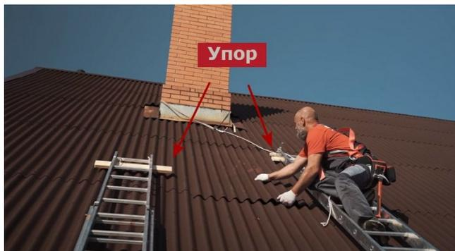
**Важно:** нельзя допускать, чтобы лестница опиралась на край листа на карнизе, иначе, лист сломается. Если скаты крыши имеют небольшой уклон, лестницу можно опереть на лобовую доску или на стену.
