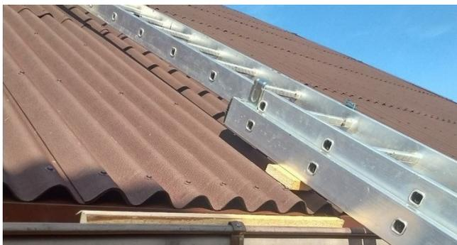
Правильный монтаж кровельной лестницы важен как с точки зрения безопасности для рабочих, выполняющих работы на крыше, так и с точки зрения сохранности самого кровельного материала. Лестница не должна деформировать его, оставлять вмятины или трещины, иначе в дальнейшем могут образоваться протечки.
