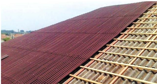
Вы думаете, что ремонт старой кровли – это долго, сложно и дорого? Мы готовы опровергнуть такое предубеждение. Существует простой, практичный и недорогой способ монтажа нового кровельного покрытия прямо поверх старого – система "капюшон"
