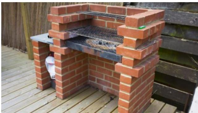
Чтобы защитить угли от сильного ветра, рекомендуется использовать металлический экран с отверстиями. Для защиты рабочей зоны мангала от дождя и снега необходимо изготовить крышку из любого подходящего материала. Чтобы стены не впитывали влагу, мангал из кирпича на даче следует покрыть лаком, например, КО-85.
