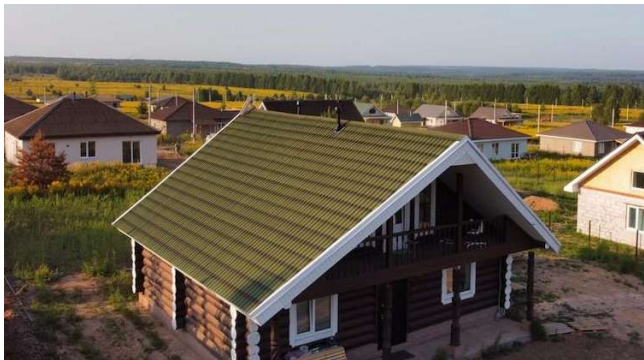
Двускатная крыша с зелёной Черепицей Ондулин.
