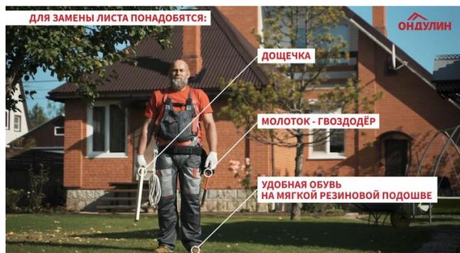
Первый шаг – аккуратно достаём гвозди с помощью гвоздодёра и дощечки и снимаем повреждённый лист.
