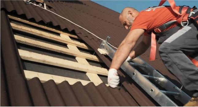
Третий шаг – прибиваем лист, соблюдая требуемое число гвоздей на лист, правила и порядок их забивания. Специальная разметка под гвозди позволит сохранить ровную линию и обеспечит красивый рисунок на кровле.
