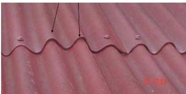
Недостаточное использование гвоздей и плохая фиксация приводят к деформации и возможным протечкам (см. фото выше).
