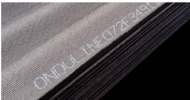
Пример маркировки на оригинальных листах ONDULINE
