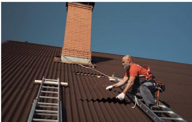
При сильном повреждении кровельного листа придется его заменить. Гвозди Ондулин нужно выдернуть, а затем снять лист. Также удаляют гвозди с листов, расположенных по периметру заменяемого листа. После этого берут новый лист и заводят его под лист, расположенный выше и далее, крепят его в соответствии с инструкцией. Ничего сложного здесь нет.
