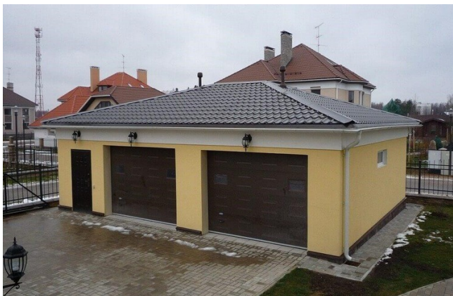
Металлочерепица на крыше гаража
