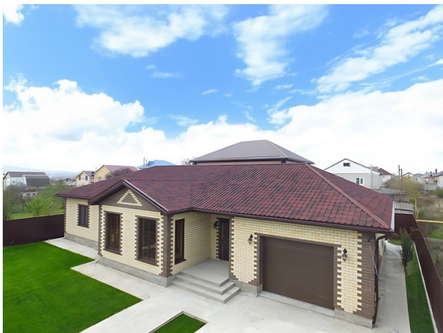
Пристроенный к одноэтажному дому гараж, покрытый Ондувиллой
