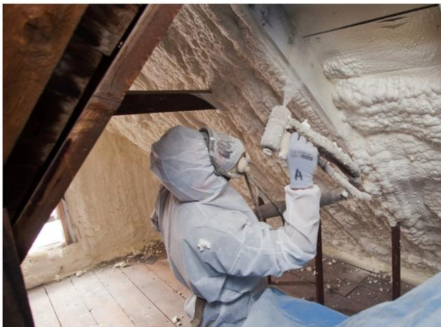
ППУ препятствует распространению звуковых колебаний. Это очень хорошее свойство для крыш, особенно, если в качестве кровельного материала используется металлочерепица или профлист, так как они сильно шумят во время дождя или града. Пенополиуретан поглощает звук за счет пористой структуры. Ячейки, наполненные воздухом, рассеивают звуковые волны, в результате чего они затухают и не распространяются дальше.
