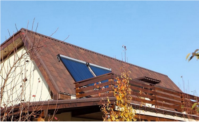
Двускатная крыша с террасой. На фото кровля Ондувилла.
