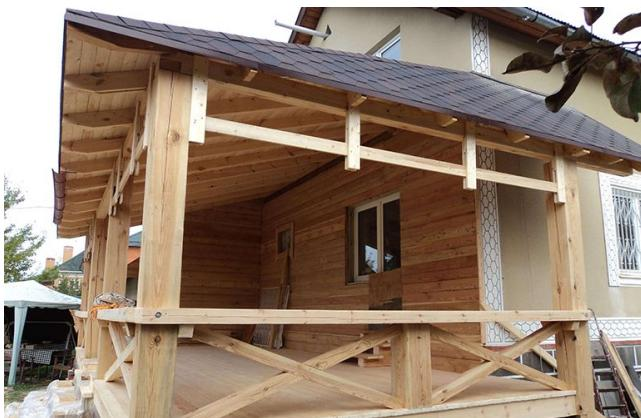
Чтобы построить веранду, хорошо защищенную от осадков (дождь, град, снег), нужно позаботиться о кровле. Самой простой считается односкатная конструкция. Этот вариант чаще предпочитают люди, которые решили построить веранду своими руками, не нанимая строителей. Важно правильно рассчитать угол наклона. Он должен быть таким, чтобы уборка снега с крыши не составляла большого труда.
