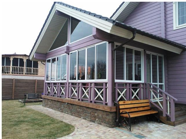
Чтобы пристройка красиво смотрелась и радовала глаз, её необходимо отдельно. В качестве материала часто применяют вагонку или доску. Ей обшивают поверхности как внутри, так и снаружи. Если помещение должно быть тёплым, то требуется утеплитель (минвата, пеноплекс).
