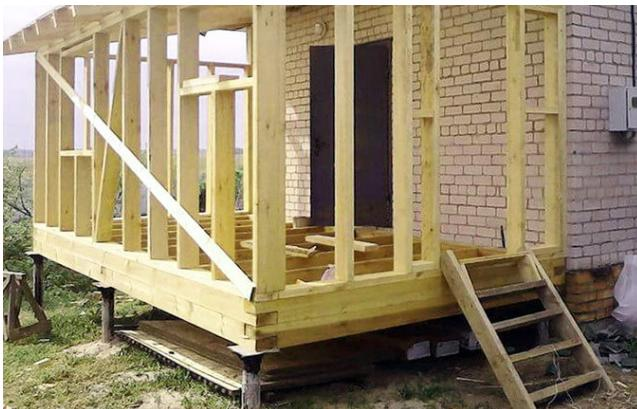
Основным строительным материалом является брус. Размер сечения для обвязки — 150x150 мм, для вертикальных стоек — 100x100 мм.
