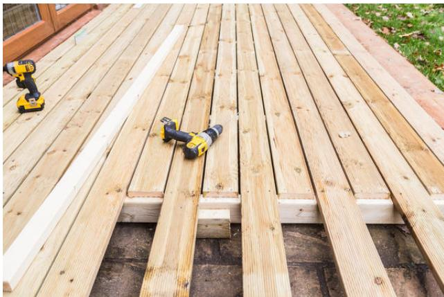
Для устройства пола на веранде понадобятся лаги. В качестве покрытия можно использовать террасную доску, изготовленную из древесно-полимерного композита. Внешне она имитирует древесину, но по своим эксплуатационным характеристикам в значительной степени превосходит её.
