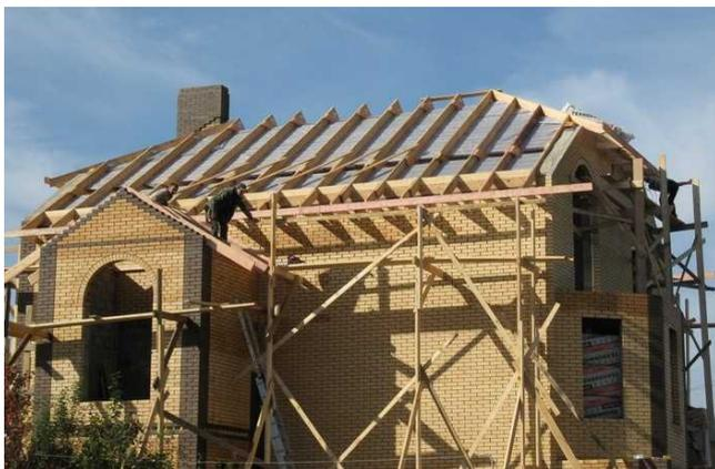
Данный вид крыши является разновидностью скатной конструкции. Поэтому для её монтажа могут применяться как наслонные, так и висячие стропила. Наслонные нижней своей частью упираются в мауэрлат, а верхней в коньковый прогон. Висячие стропила, в отличие от наслонных, упираются не в коньковый брус, а друг в друга. Вариант с наслонными стропилами многими строителями считается наиболее прочным и надёжным.
