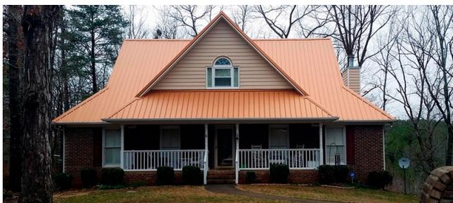
В этом случае полувальмы имеют нижнее расположение. Датские полувальмовые крыши подходят для любых построек до трёх этажей. Главная их особенность — большой угол наклона верхней части каркаса. Он достигает 70 градусов. Нижние полувальмовые скаты имеют, напротив, небольшой угол наклона около 20 градусов.
