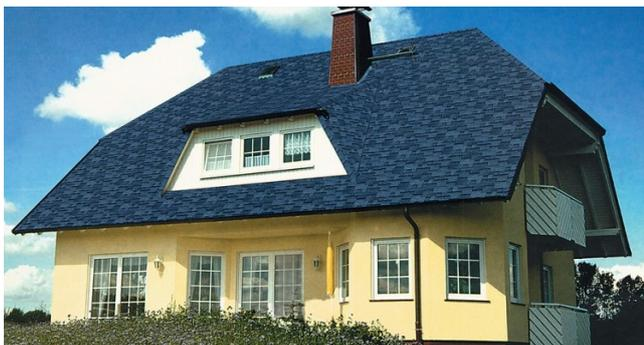
Данный вид крыши является разновидностью вальмовой конструкции. По сути, это кровля с четырьмя скатами. Два из них имеют трапециевидную форму и ещё два форму равнобедренных треугольников. При этом скаты в виде треугольников укорочены за счет фронтонов. Несмотря на сложность расчётов и проектирования, полувальмовая кровля очень популярна в загородном строительстве. Она ценится за следующие качества:
