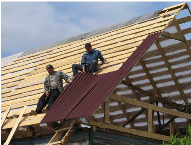
Из-за большого количества изломов, в сравнении с традиционной двускатной крышей, повышенное внимание уделяют монтажу аксессуаров. Конёк крепят с подветренной стороны, соблюдая нахлест друг на друга 12,5 см. Монтаж конька на ребре начинают снизу. Соблюдают нахлест друг на друга размером от 10 см.
