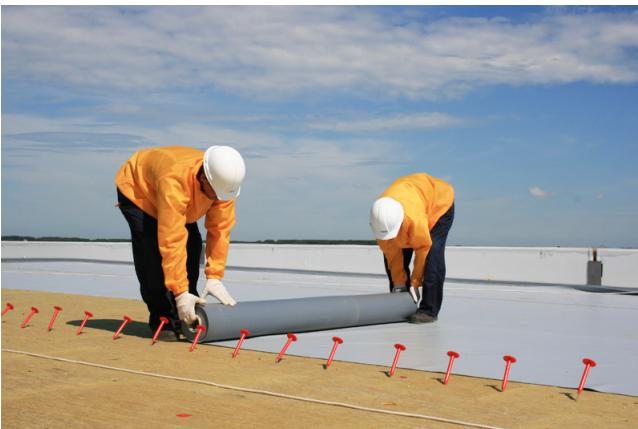
Покрытие изготавливается из поливинилхлорида. Крепится механическим способом, после чего швы обрабатываются сваркой при помощи специального оборудования.
