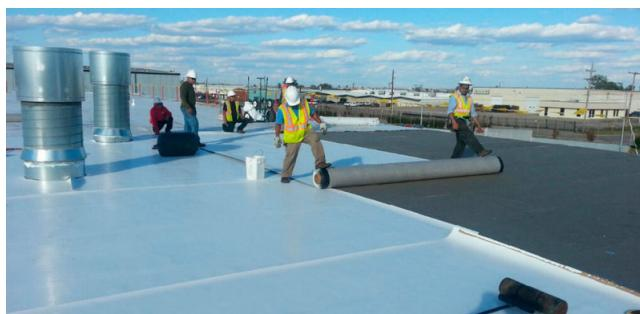
Изготавливается из термопластичных полимеров. Из ключевых качеств — морозоустойчивость, отсутствие вредных для экологии компонентов. Материал армирован полиэстером. Монтируется при помощи горячего воздуха.
