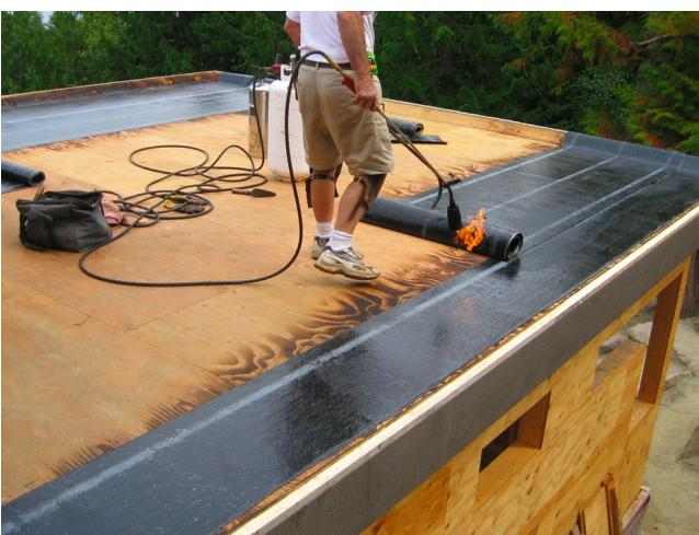
Отличаются по составу, а также по способу монтажа. Их наклеивают при помощи мастики, наплавляют, разогревая горелкой или крепят механическим способом. Также есть самоклеящиеся битумные покрытия.
