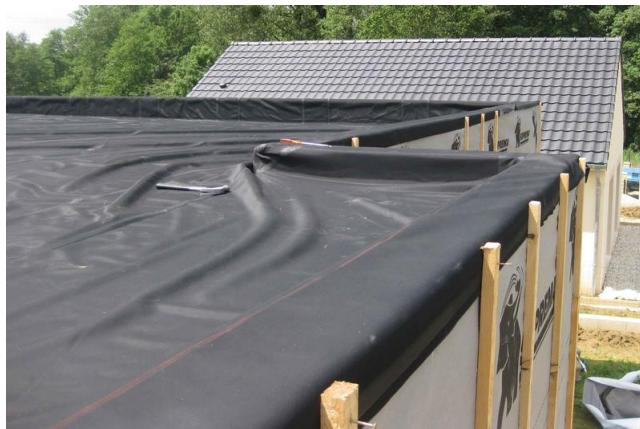
Данное покрытие имеет высокую стоимость. Основа материала — этилен пропилен диеновый каучук. Обладает хорошей эластичностью, но не так надёжен, в сравнении с другими вариантами. Крепится при помощи самоклеящейся ленты.
