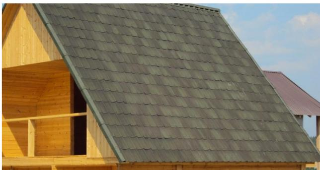
У ондулина масса преимуществ перед другими кровельными материалами (например, металлочерепицей или профнастилом). Ондулин не требует специнструментов для монтажа, будет достаточно ножовки, молотка и ножа. Для профнастила вам понадобится как минимум болгарка и умение ею пользоваться. Перевозить ондулин можно в легковой машине, не нужно задействовать спецтранспорт. Ещё ондулин не ржавеет, не нагревается и не требует особого ухода.
