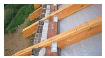
Мауэрлат — это опорный элемент стропильной системы, который принимает нагрузку от стропил и передаёт её через стены на фундамент.
