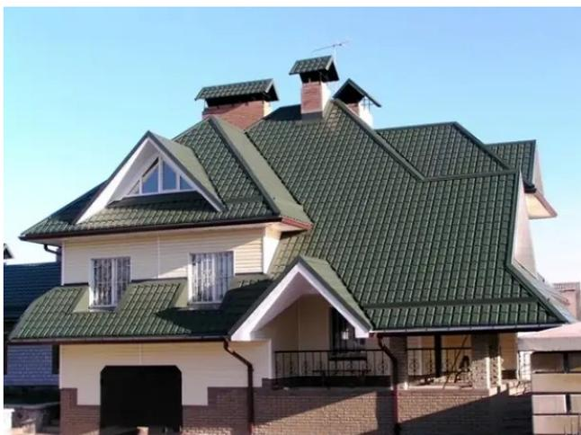
На этой фотографии ломаная крыша дома покрыта металлочерепичной кровлей. При выполнении работ нужно особое внимание уделить гидроизоляции внутренних углов, чтобы в дальнейшем избежать протечек. Без соответствующего опыта за такую работу лучше не браться. Монтаж стоит доверить опытным кровельщикам. Также нужно учесть такие минусы металлочерепицы, как шумность и сильное нагревание на солнце.
