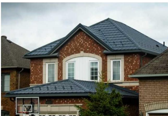
Если четырёхскатная вальмовая крыша покрыта металлическими кровельными материалами, то нужно заранее подумать, как избежать внезапного схождения снега. Для этого необходимо установить снегозадержатели.
