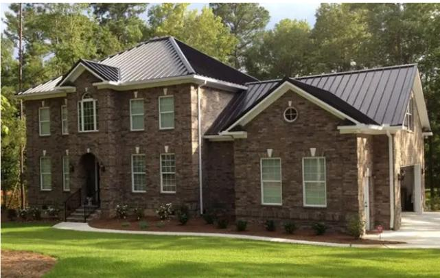
Вальмовая крыша является разновидностью двускатной крыши. Её отличительная черта — два ската в форме трапеции и два ската в виде треугольников.
