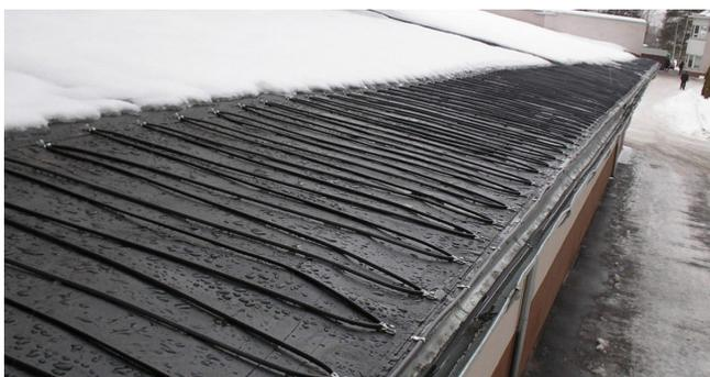
Чаще всего используются кабельные антиобледенительные системы: они экономичны, эффективны, относительно просты в монтаже и эксплуатации. Принцип работы кабельной системы заключается в том, что нагревательные элементы (кабели) прокладывают в местах, где скопление больших снежных масс и наледи наиболее опасно — в ендовах, на карнизах, в водосточных желобах и трубах.
