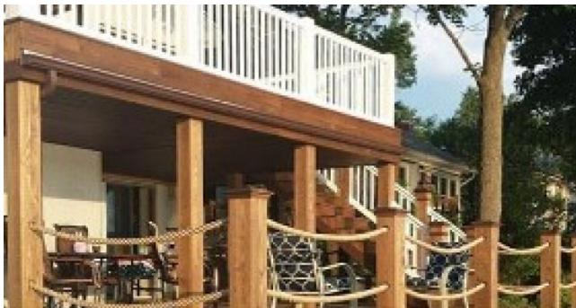
Терраса — это открытая площадка, которая **базируется на фундаменте или специальных опорах**. Для террасы используется столбчатый, ленточный, винтовой или свайный тип основания, выбор которого зависит от назначения планируемой постройки. Пристройка возможна и без фундамента. В этом случае несущие балки ложатся на опоры, в основании которых лежит тротуарная плитка или подобное по надёжности покрытие.
