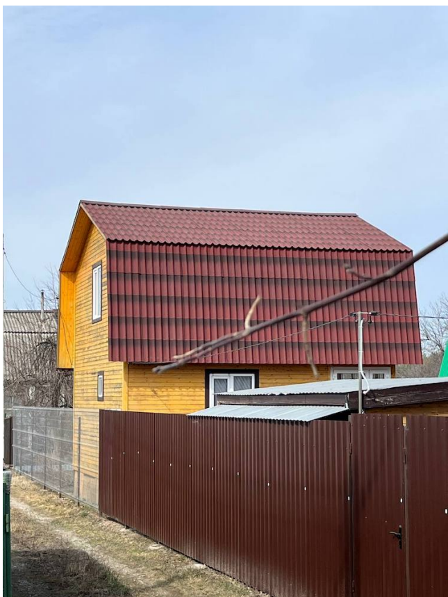
Төбесінде Ондулин тақтайшалары бар үй. Қазан маңындағы СНТ "Березкада" салынған.
