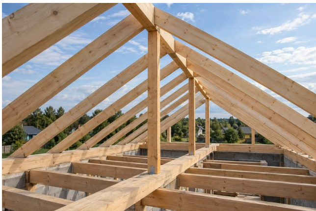
Крыніца: onduline. Наслонная кроквенная сістэма.
