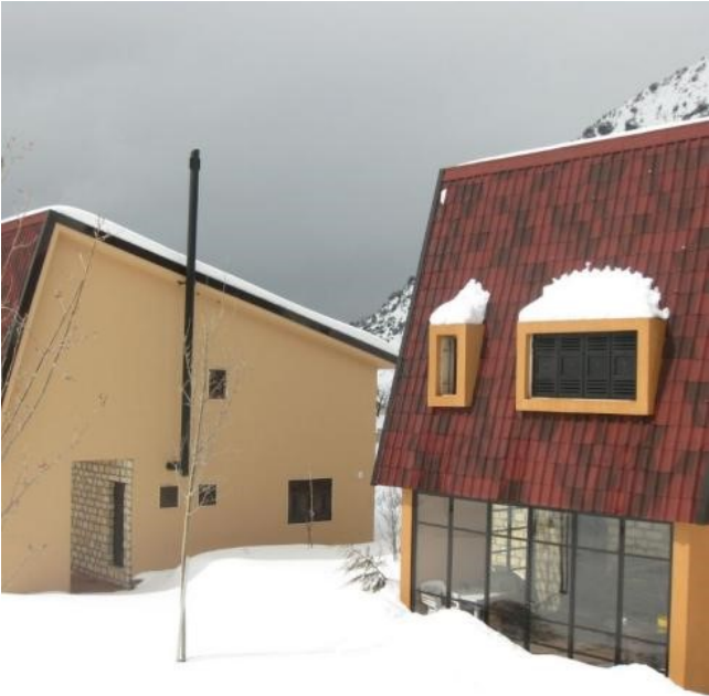
На фота невялікія загарадныя дамы з Ондувілам на асіметрычным двухсхільным даху.
