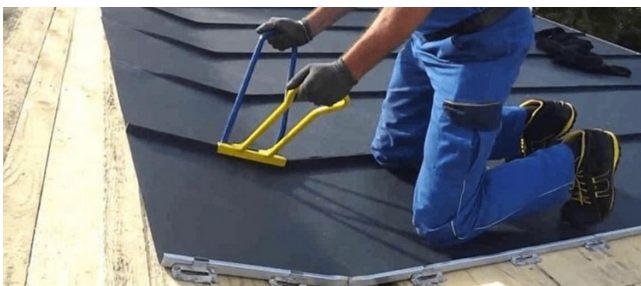
Монтаж фальцавага даху
